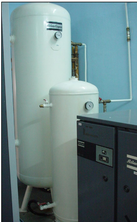
Bình trữ khí nén (Reservoir cylinder)
